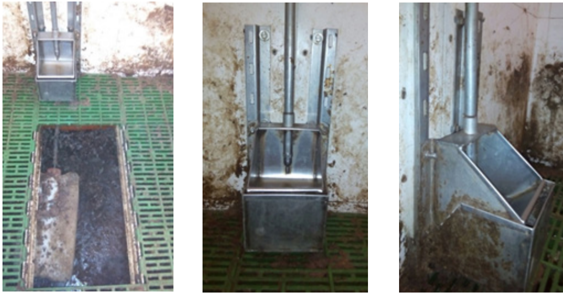
Figura 27. Disposición de la cazoleta suplementaria instalada en condiciones de trabajo.
